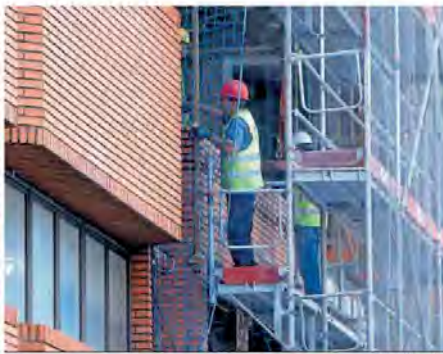
Tras el parón del confinamiento, la construcción retornó su ritmo en 2020.
